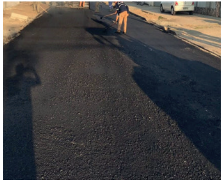
12. Rua Jequitibás sendo pavimentada – Jardim Iguacú
