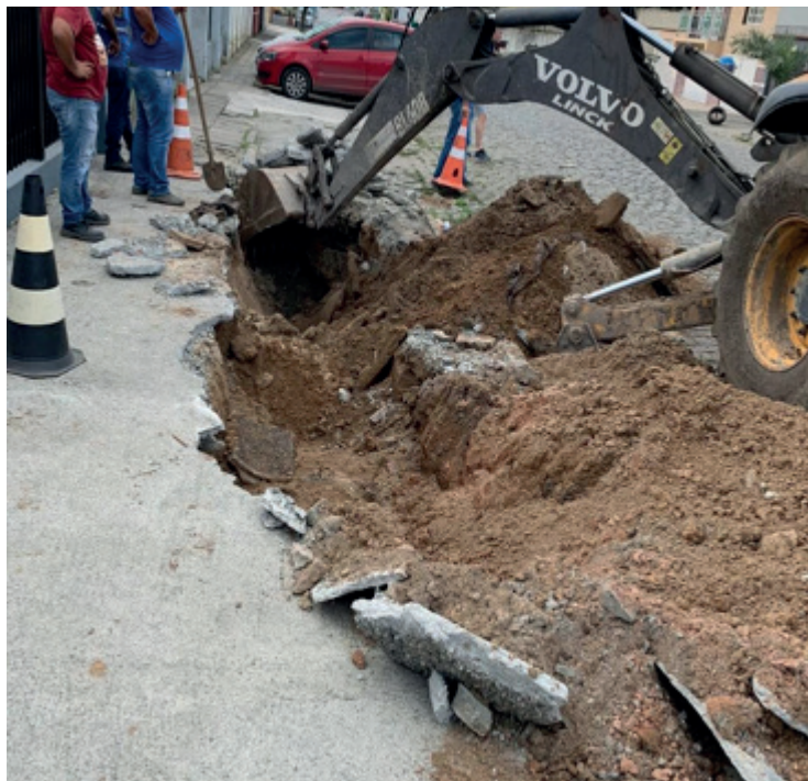
11. Equipe de drenagem verificando erosão – Centro Histórico
