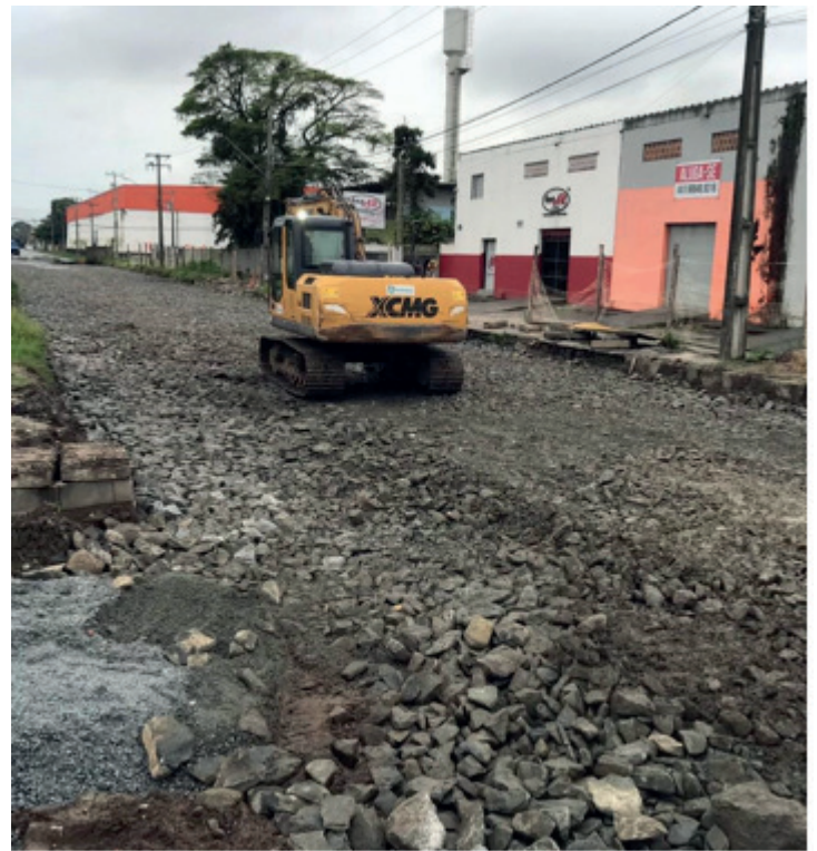
6. Nivelamento sendo executado na Rua Professor Cleto - Rocio
