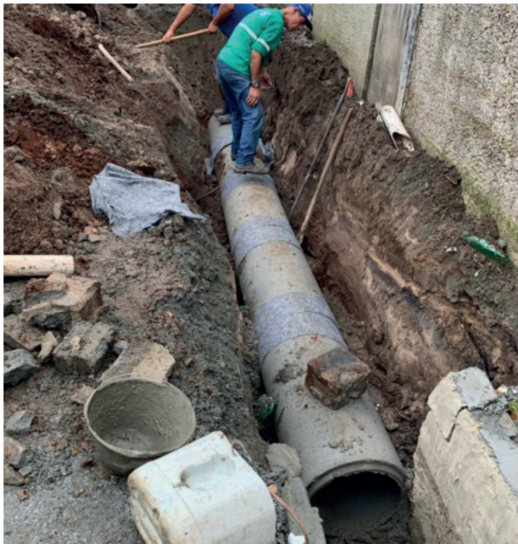
9. Rede de drenagem sendo executada na Rua Padre Adelir – Jardim Iguacú
