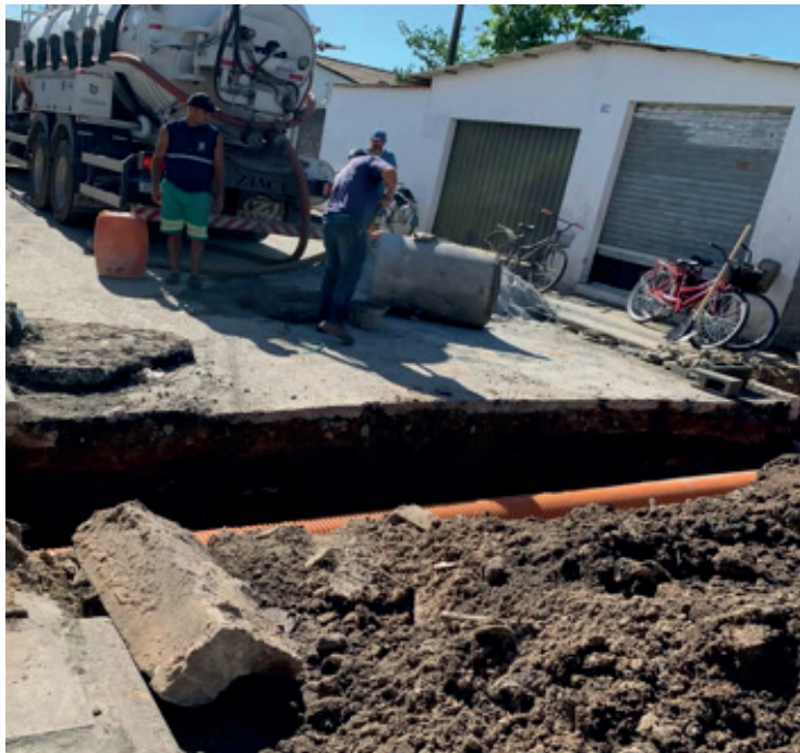
4. Rede de drenagem sendo executada no Bairro São Vicente
