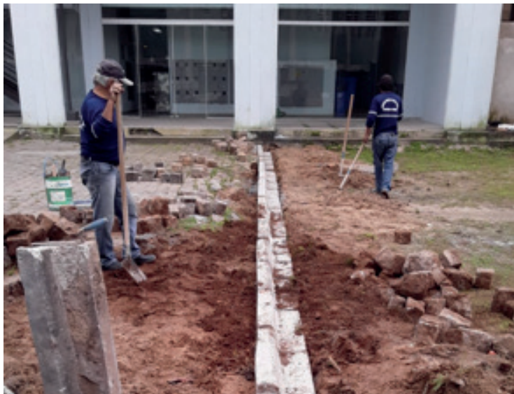
Preparação de concreto para serviços externos
