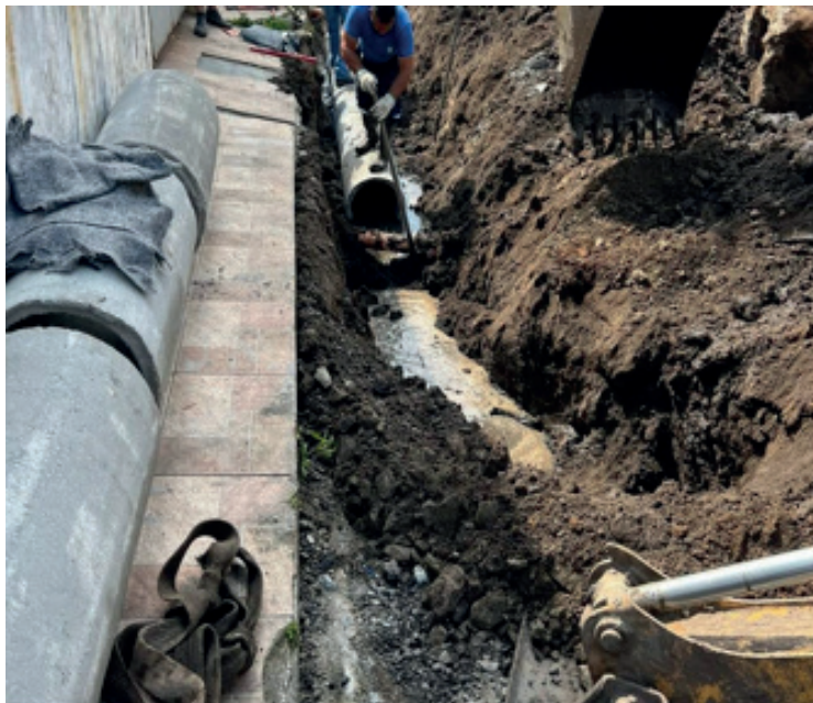
16. Equipe colocando manilhas para nova rede operar
