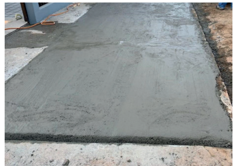
13. Equipe realizando calçada após solucionar erosão na rede de drenagem
