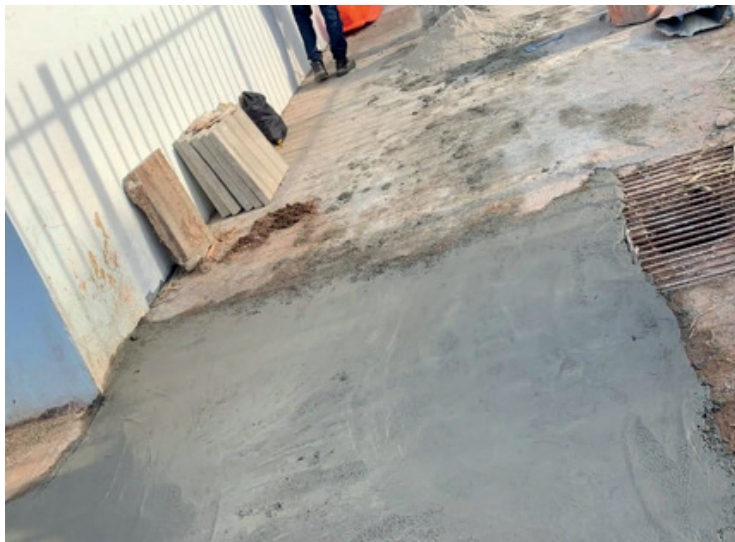
10. Calçada sendo executada em uma escola do município – Centro Histórico
