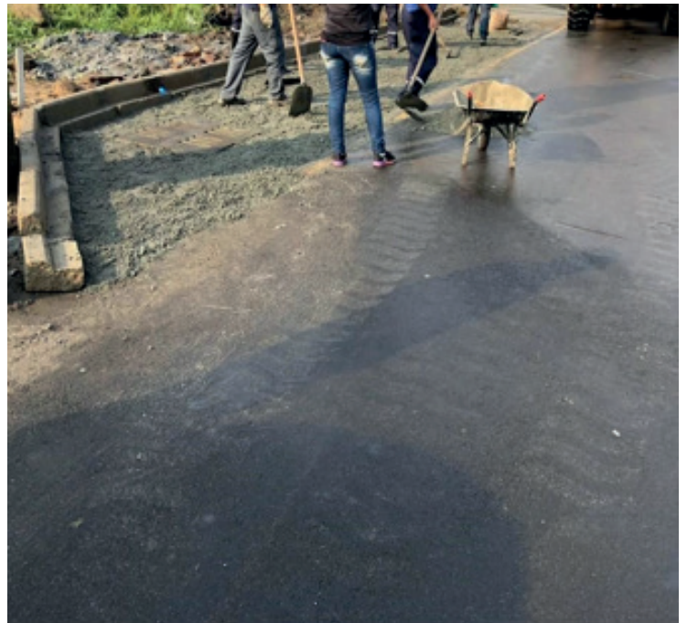
19. Estacionamento sendo feito – Vila do Povo
