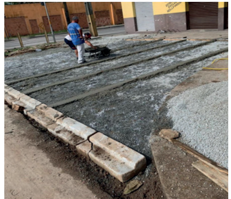
8. Calçada sendo executada na Av. Roque Vernalha – Vila Guarani
