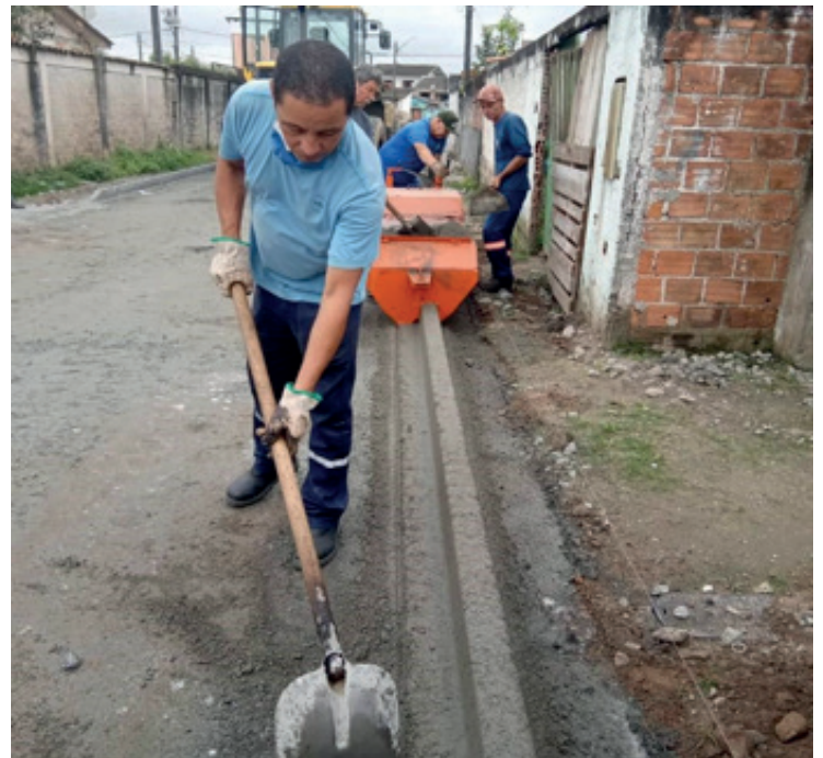
24. Meio-fio sendo realizado na Rua Copaibas – Jardim Iguacú
