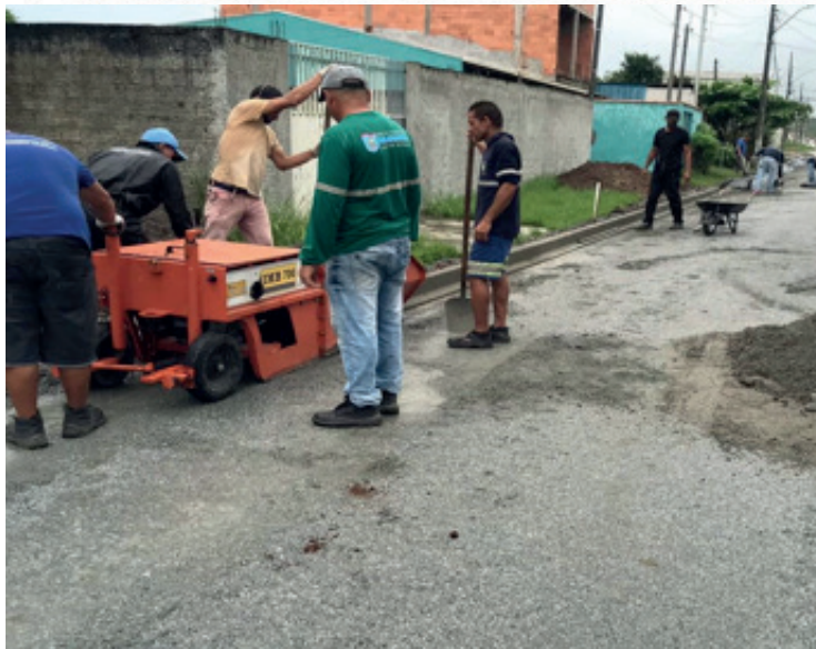
5. Meio-Fio sendo executado na Rua Jequitibás – Jardim Iguaçu
